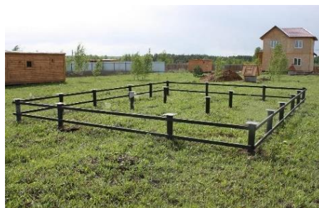
Рисунок 82. Установка свай
