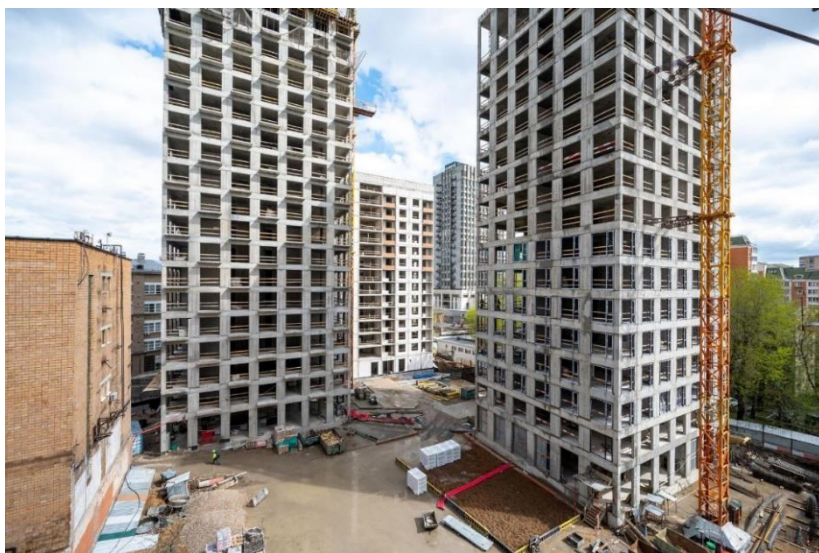
Рисунок 6 – Состояние объекта на апрель 2024
