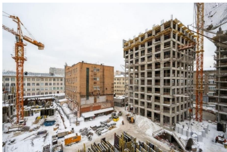
Рисунок 5 – Состояние объекта на январь 2024
