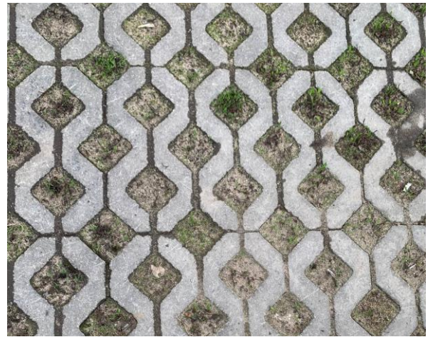
Фото 8. Покрытие из плитки «Экопарковка»
