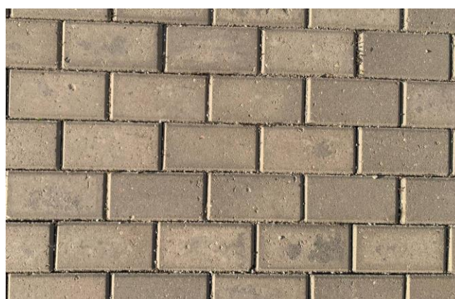
Фото 6. Покрытие из плитки (пешеходная нагрузка)
