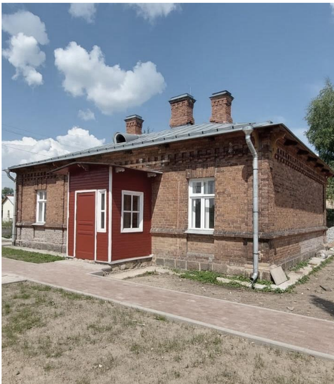
Здание, где будет располагаться музей железнодорожного наследия
